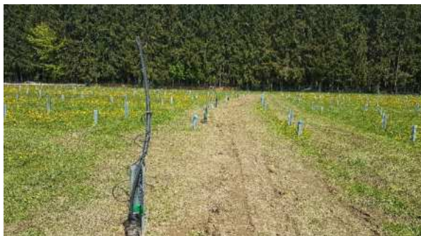
Abbildung 2: Verfüllter Kabelgraben
